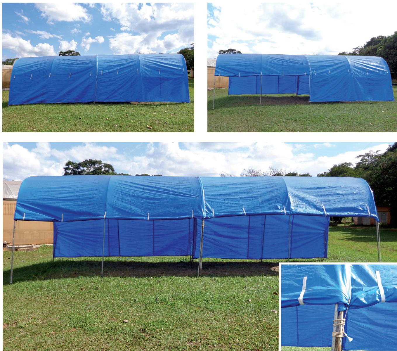
Figura 6 – Abertura e ventilação da estrutura e fixação da lona com velcro.
