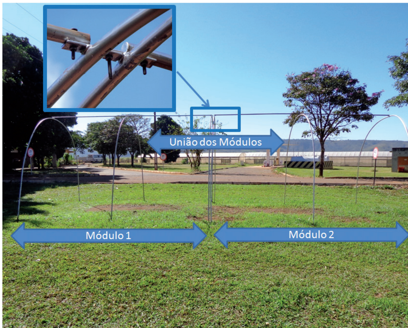
Figura 2 – Montagem e União das duas UMS.
